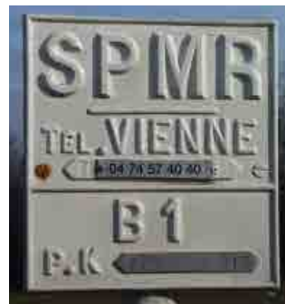
Signalisation de la présence de canalisations (gazoducs et oléoducs)
