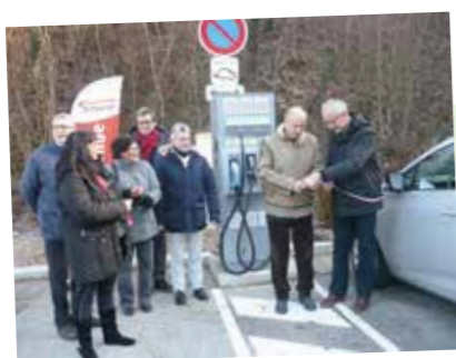
Le 13 février 2019, inauguration de la borne électrique SYANE située sur le parking Maison Blanche à Étrembières.
