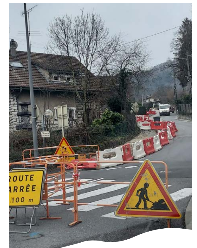
Travaux Chemin Cret de la Croix
