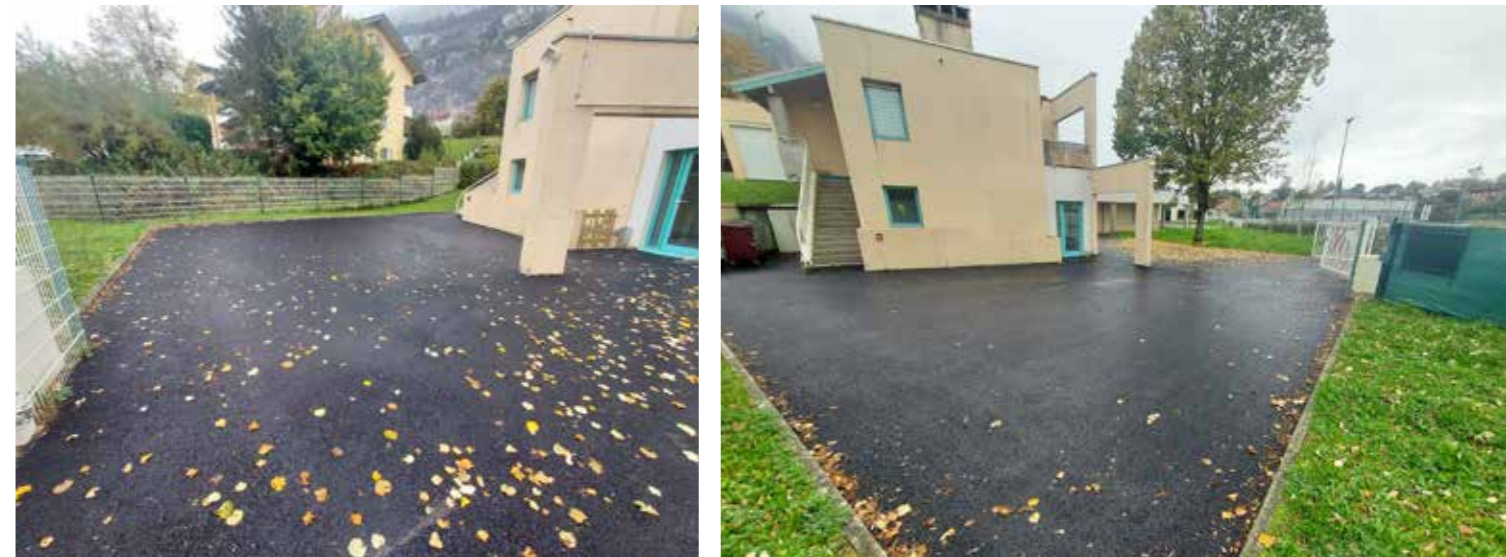
TRAVAUX À L'ÉCOLE JEAN-JACQUES ROUSSEAU
