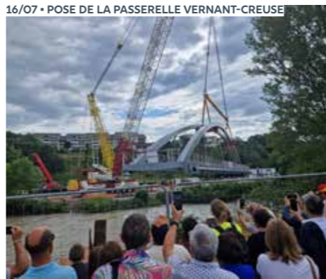
16/07 • POSE DE LA PASSERELLE VERNANT-CREUSE
