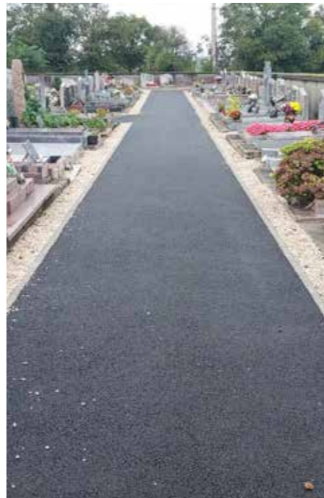
RÉFECTION DE L'ENROBÉ DU CIMETIÈRE - 1 ÈRE TRANCHE
