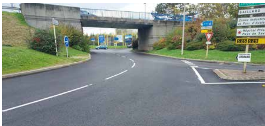
RÉFECTION DE L'ENROBÉ - ROND POINT MIGROS
