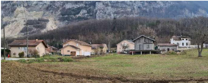
Logements individuels du Pas de l'Echelle (Epode, 2023)
