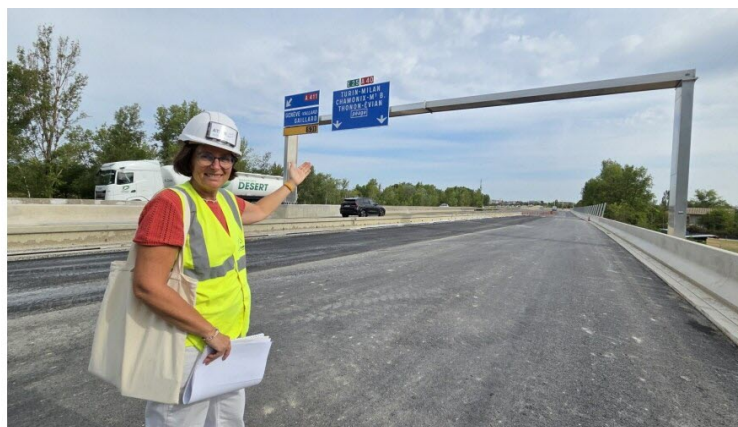
Carole Daguet, cheffe de projet investissement à l'ATMB, en plein cœur du chantier. La bretelle de la sortie 14, plus large, passera de 400 à 1 100 m. Photo S.Pe.
